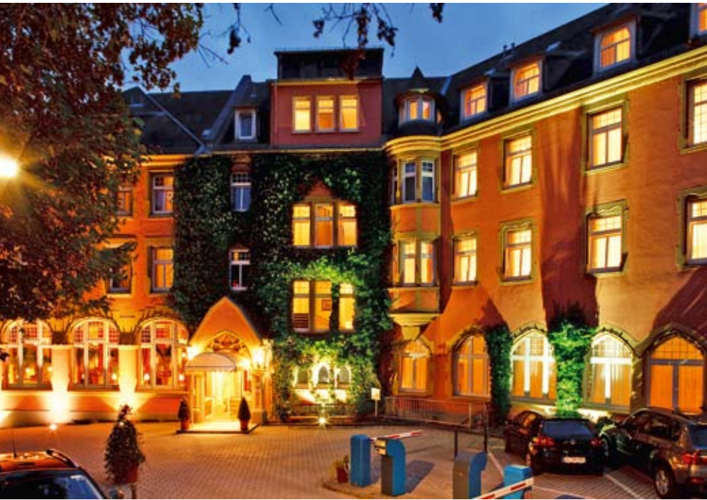
Das Hotel „Oranien“ in Wiesbaden ist bereits auf die HDTV-Technik umgerüstet.
